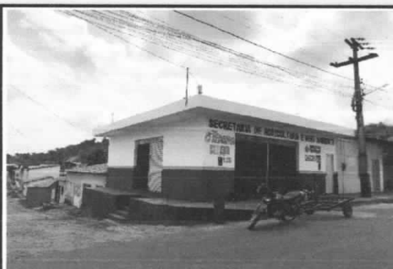
FOTO 03 - ENTRADA SECUNDÁRIA - ESQUINA
